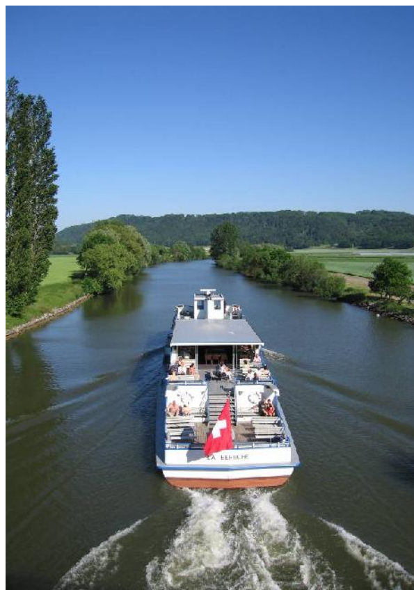
Exemple d'une bonne intégration, le Canal de la Broye
